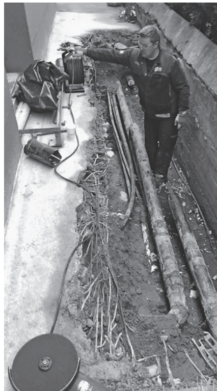
„Reparatur eines Leitungslecks hinter dem Vinomnasaal“
