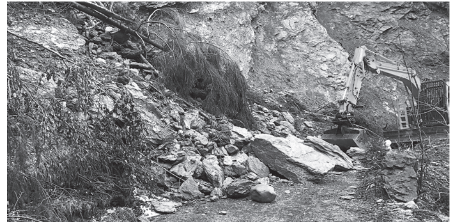
Beseitigung von Felsstürzen im Netschel
