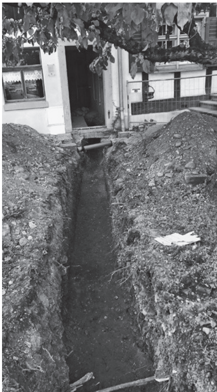
„Das Schlosser-Ammann Haus wurde im Herbst an das Fernwärmenetz angeschlossen.“
