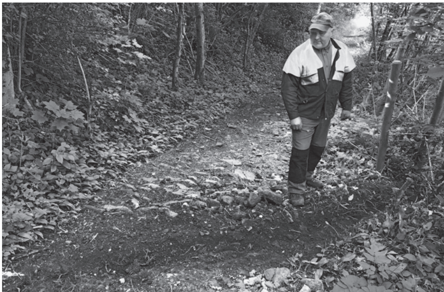
Wasserleitungen nach Starkniederschlägen, Harald Domig
