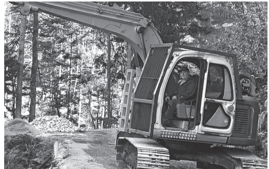
Forststraßensanierung im Bereich Plattentobel, Harald Domig
