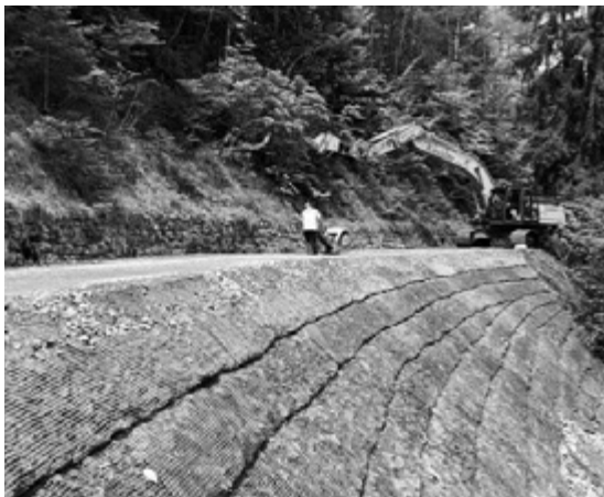
Sanierung mit bewehrter Erde
