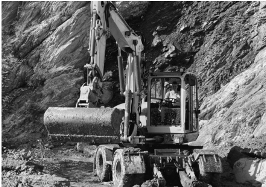
Forststraßensanierung David Meyer
